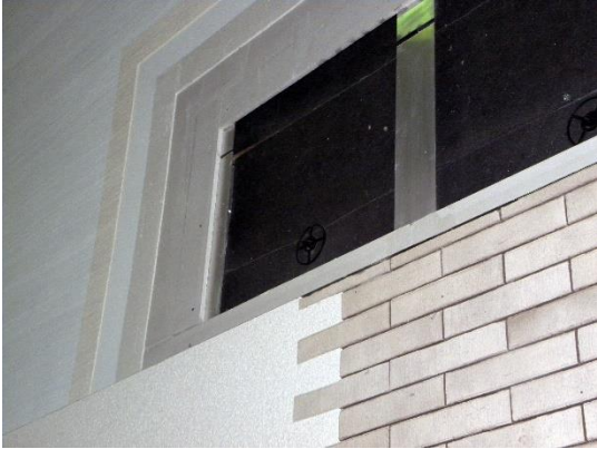
Abb_1: In der neuen Fassadenwerkstatt im Branchenzentrum in Rutesheim gibt es eine lebensgroße VHF als Muster und Schulungsobjekt. Hier im Bild sieht man den Schichtaufbau am Beispiel einer verputzten VHF.
