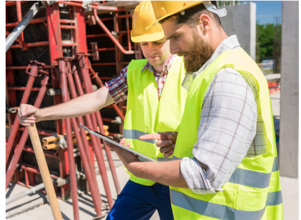
Baustellenabsprache mit Zugriff auf zentrale Baudaten (Bild: fotolia)
