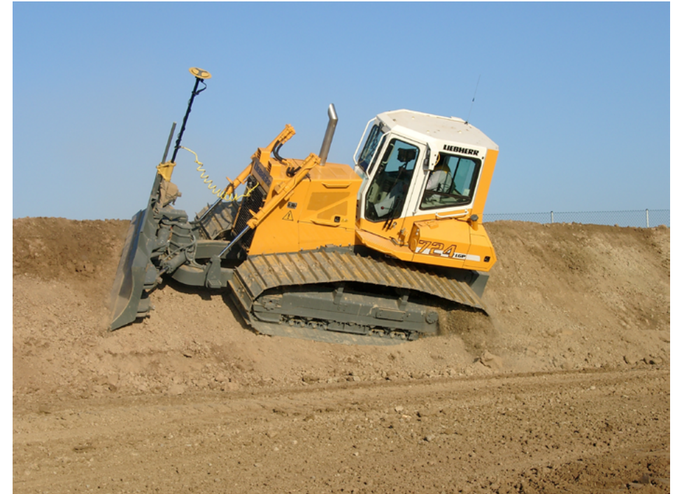
Planierraupe mit GPS-Steuerung (Bild: AFZ Walldorf)
